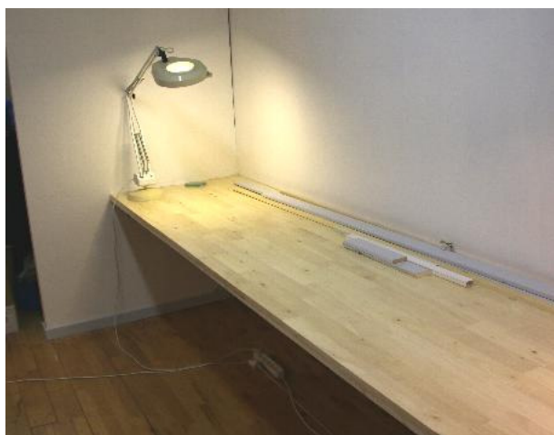
Arbejdsbordet med fodlister og bordben monteret
