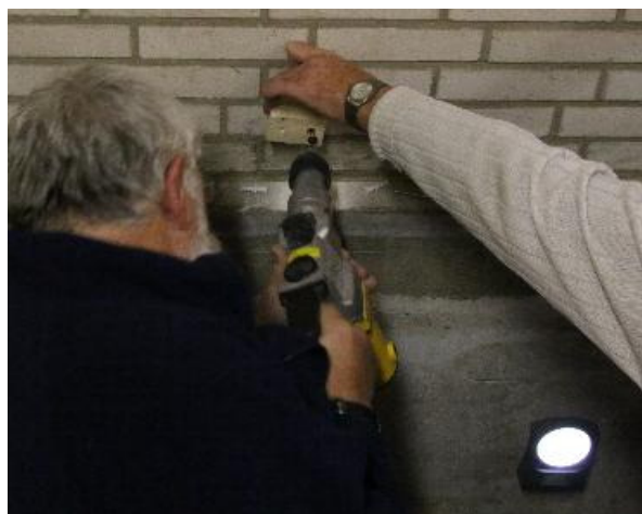
Der opsættes gelænder ved trappen
