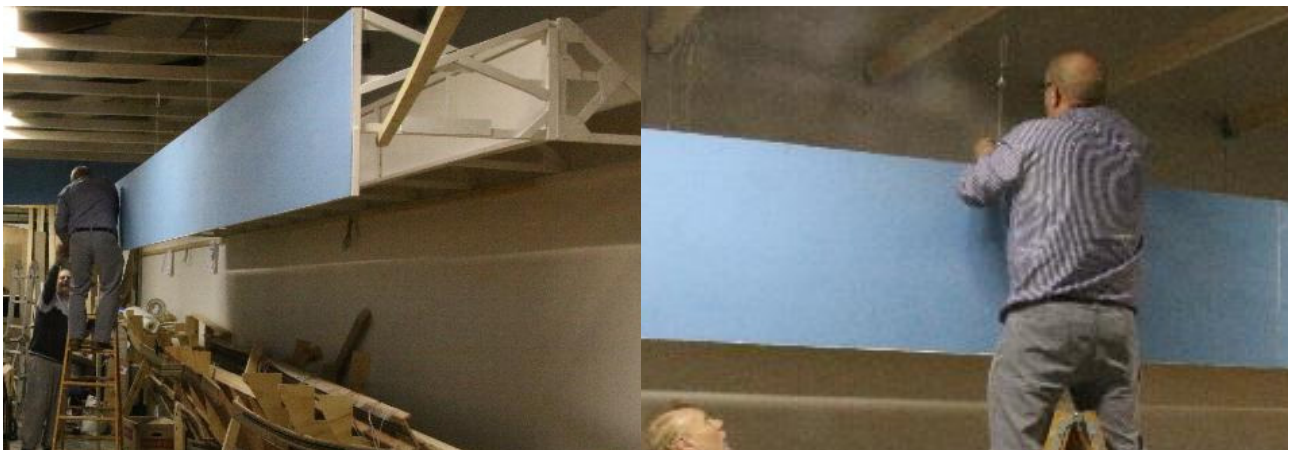
3 lyskasser er monteret – i alt ca. 7,2 m Bærewirer fastgøres på fronten og op i loftet
