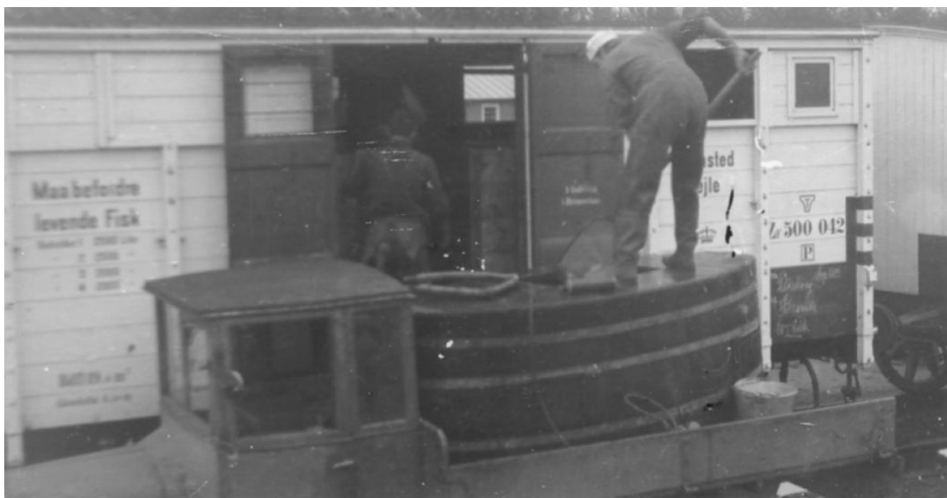
ZF 500 042 i Vejle 1932, Det er så vidt jeg ved det eneste foto, der viser så meget frem af en Q vogn forklædt som ZF vogn. Alle (?), de for Q vognene så karakteristiske lemme øverst på vognsiden, er tilsyneladende fjernet og / eller erstattet / forsynet med diverse vinduer. På venstre side af døren er lemmene erstattet (?) af en lang lem.
