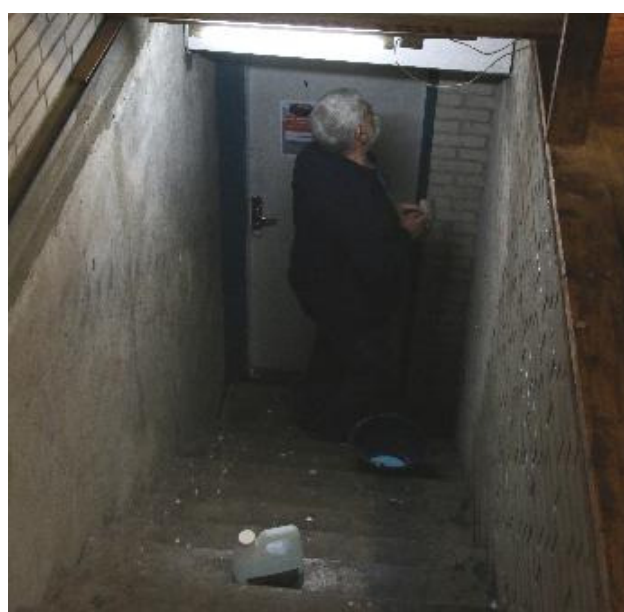
Der gives forankringsgrunder og spartel inden maling af trappeskakten
