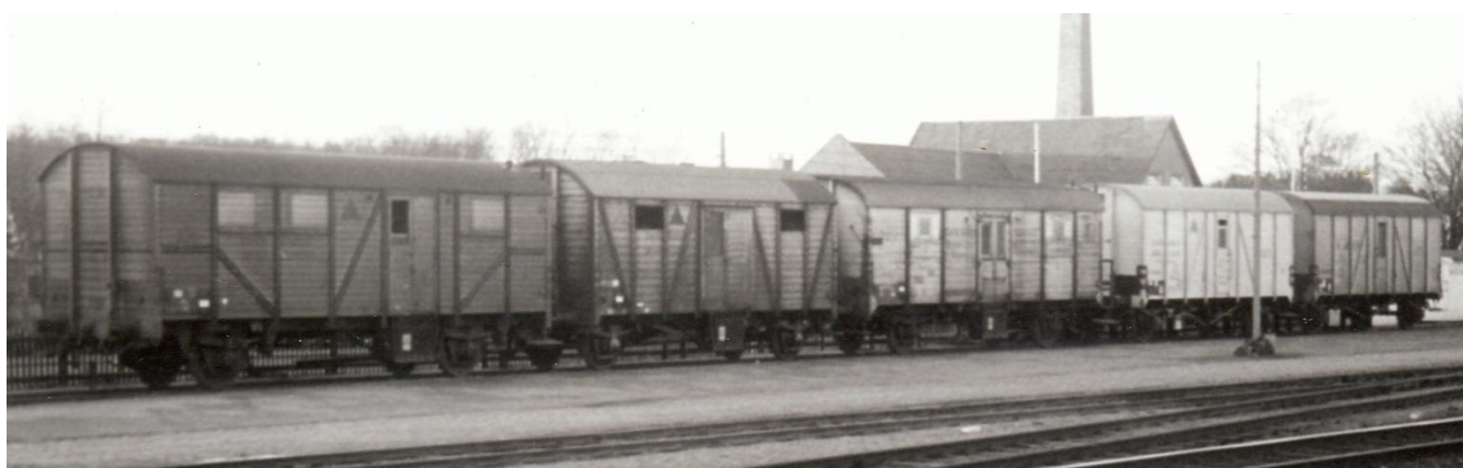
Vi slutter denne afdeling med et udsnit af afslutningsbilledet fra sidste nummer. Det rummer jo en del rariteter. Første vogn er ZF 500 077 en sjældent fotograferet vogn. Anden vogn er ZF 500 072 efter ombygningen og med gasanlæg monteret, heller ikke denne vogn er der mange billeder af. Tredje vogn er ZF 500 011 i sidste udgave, ligeledes med gasanlæg monteret, også sjældent fotograferet. Fjerde vogn er ZF 500 074, nu med læsselemme! Sidste vogn er ZF 500 064 en meget fotograferet vogn!! Men vi har her 4 af de dårligst dokumenterede vogne fra Dansk Andels Ørred Eksport, på et foto - godt skudt!
