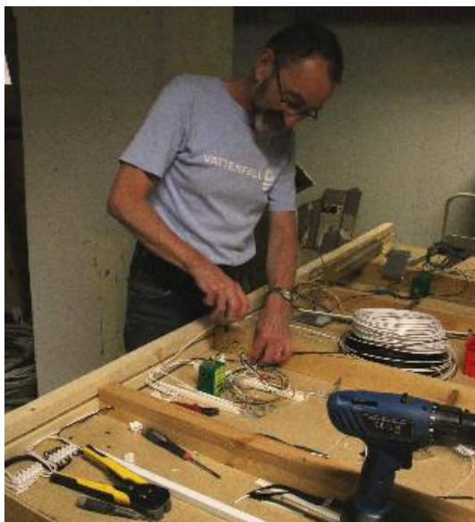
Der trækkes ledninger
