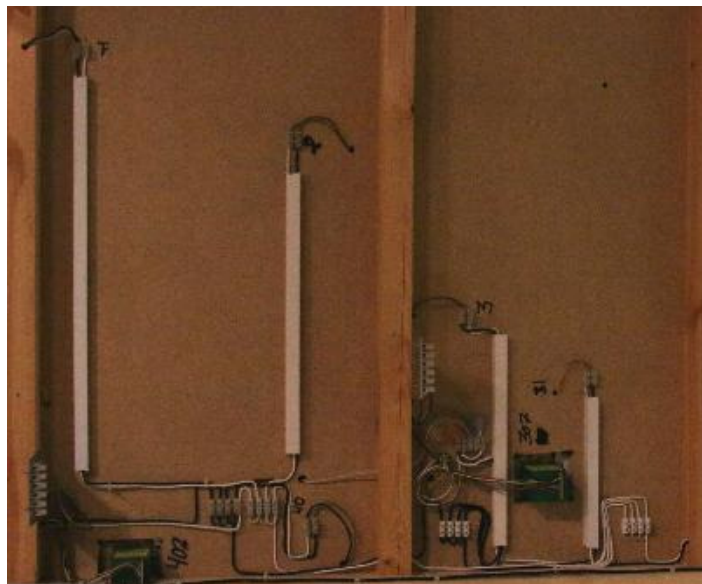
Den færdige elinstallation på en sektion
